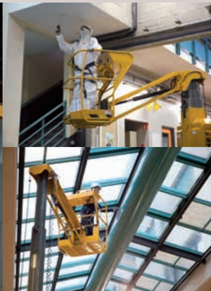
TRABAJOS DE OBRA MENOR EN INTERIOR
