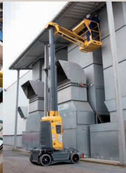
MANTENIMIENTO Y TRABAJOS DE OBRA MENOR EN EXTERIOR
